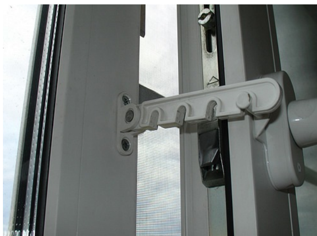
Рисунок 11 – Фиксатор открытия для пластиковых окон
