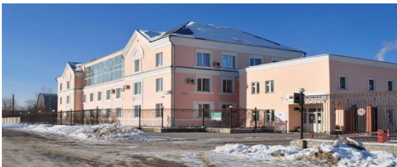
Рисунок 1 – Здание Свердловского путевого ремонтно-механического завода «Ремпутьмаш»
