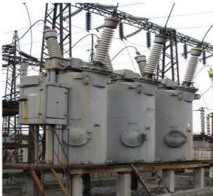
Рисунок 1 - Внешний вид масляного выключателя МКП-110
