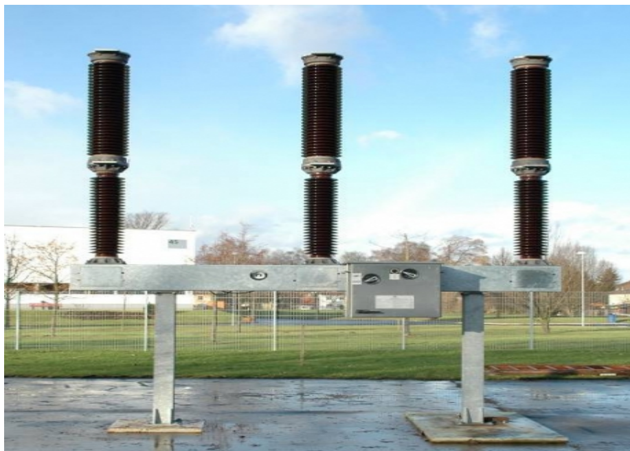
Рисунок 2 – Элегазовые колонковые выключатели 110 кВ
