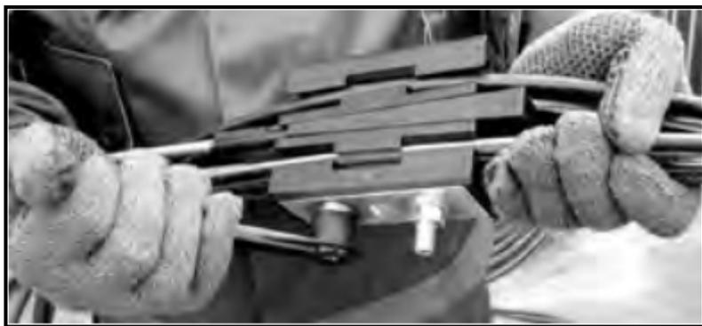
Рисунок 9 – Затягивание гаек зажимных винтов
