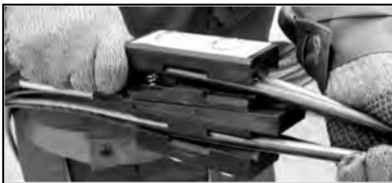
Рисунок 8 – Укладка провода в анкерный зажим
