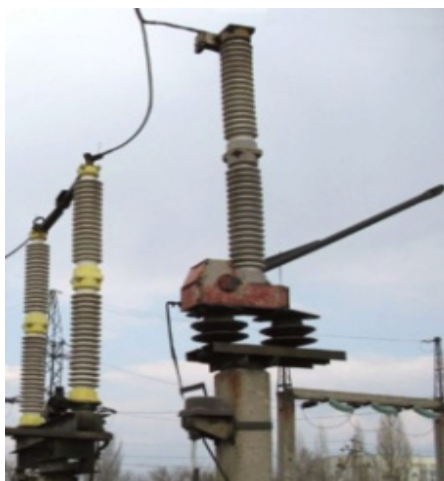
Рисунок 5 - Внешний вид короткозамыкателя КЗ – 110
