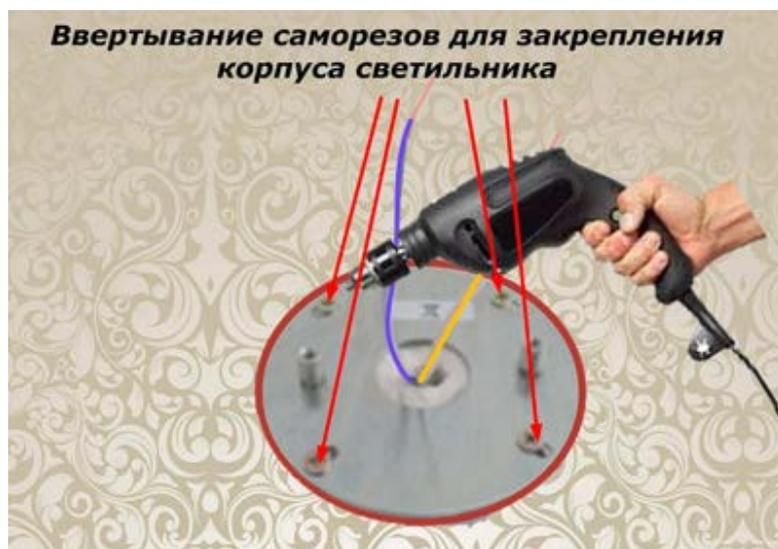
Рисунок 17 – Монтаж корпуса светильника
